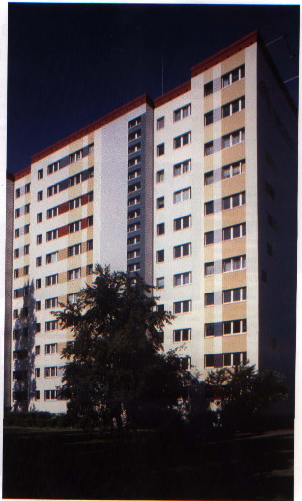
Sanierte Wohngebäude in der horizont Wohnungsgenossenschaft eG
